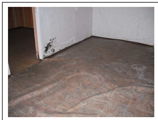
az iroda felpúposodott burkolata
